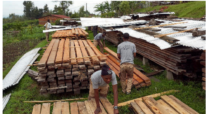
/ Der von Schädlingen befallene Holzbestand der Schule, mit ca. 100 m 3 einer der größten des Landes, muss kontrolliert und die befallenen Bohlen aussortiert werden.
